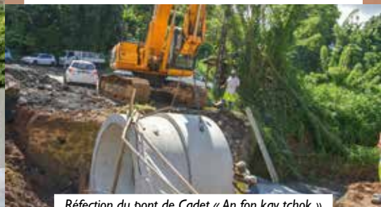
Réfection du pont de Cadet « An fon kay tchok »
