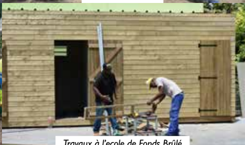
Travaux à l'école de Fonds Brûlé
