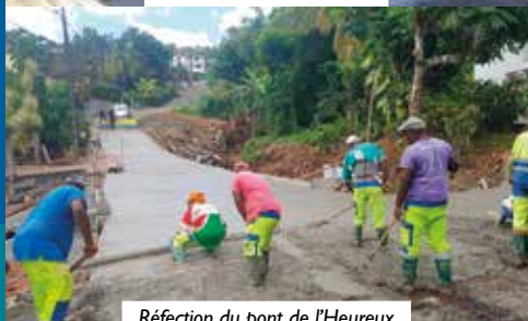
Réfection du pont de l'Heureux
