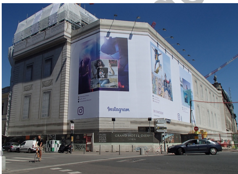
Bâche sur échafaudage (photo prise dans une ville autre que Le Robert)
