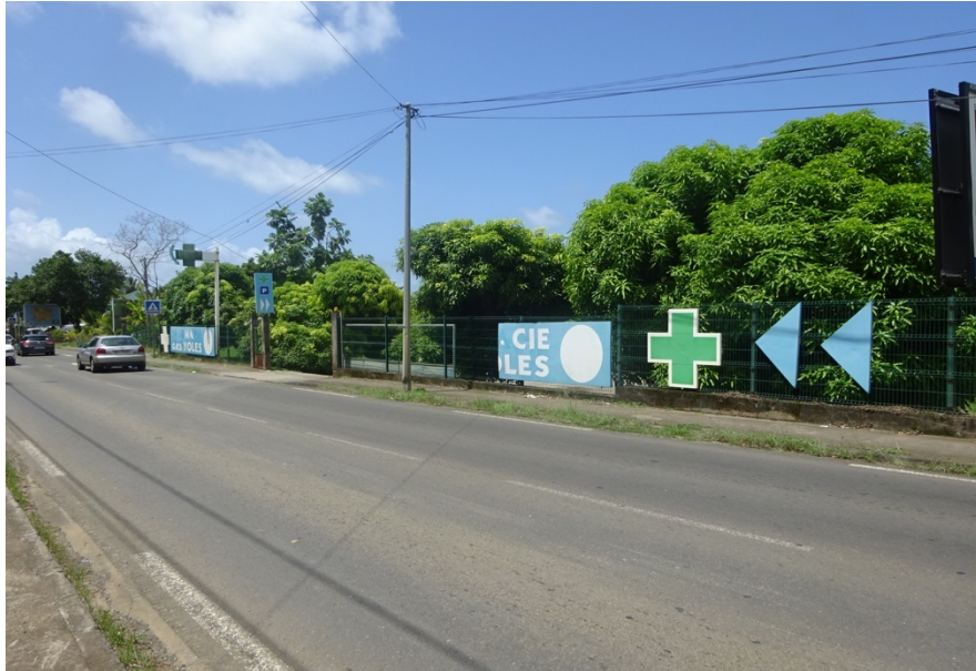
Enseignes sur clôture mal entretenues
