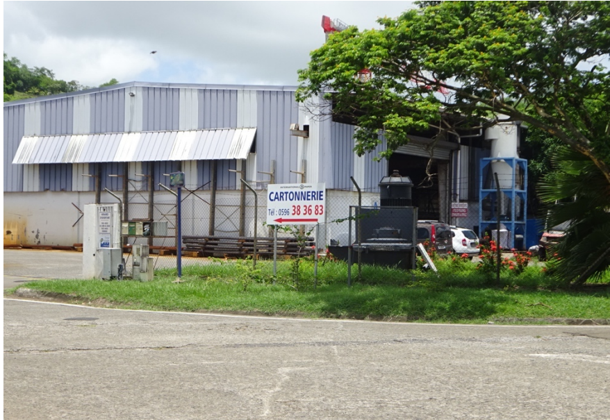
Enseigne scellée au sol
