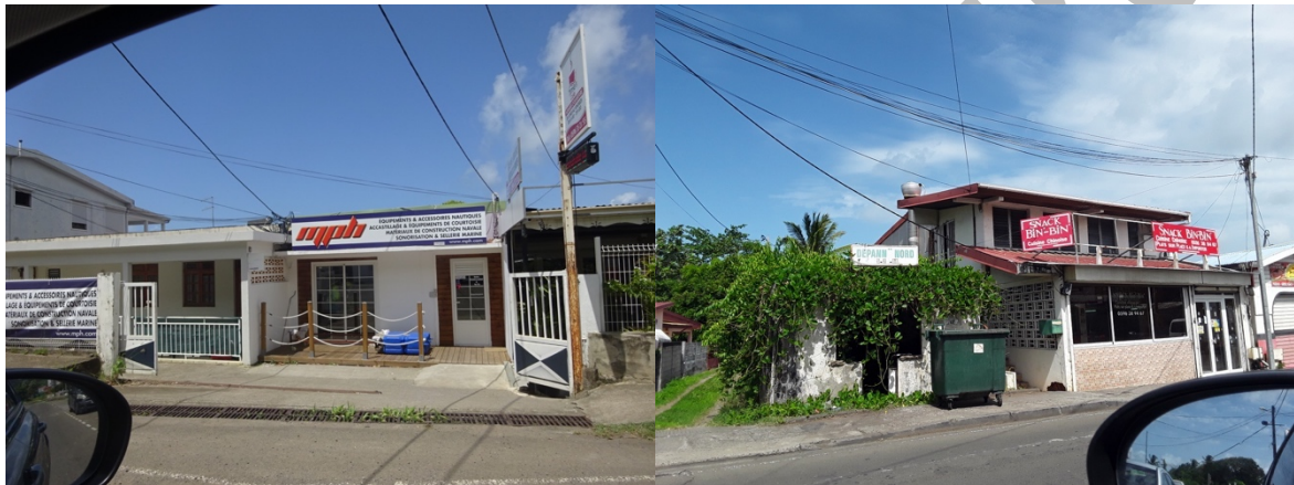
Enseignes en toiture illégale
