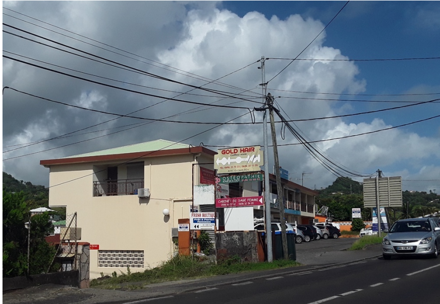
Enseignes scellées au sol mal organisées
