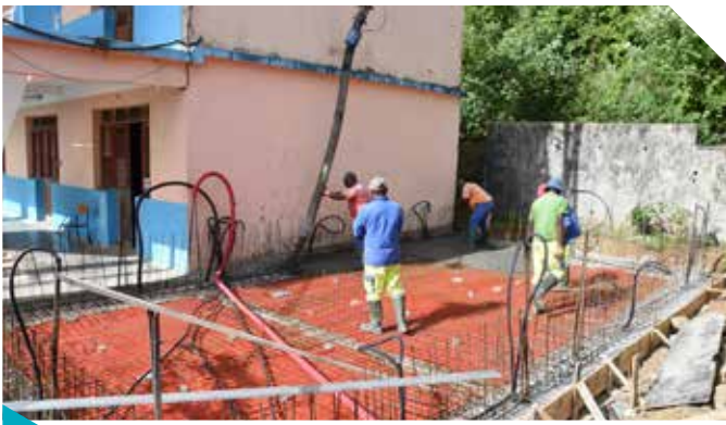
Création de 2 salles de classes supplémentaires à l'école de Four à Chaux
