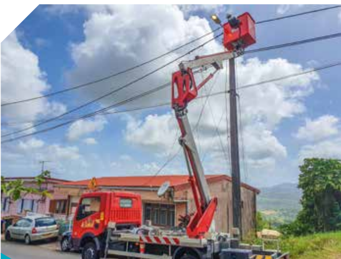
Rénovation de l'éclairage public dans les quartiers
