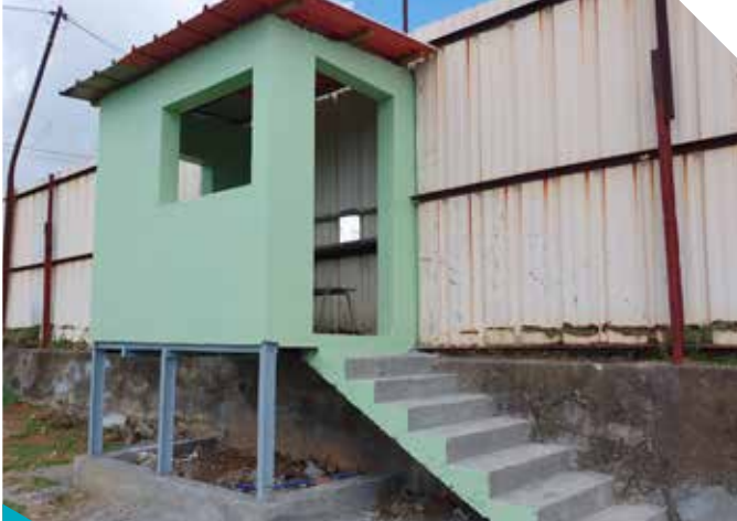
Travaux au stade Georges Spitz : réfection du guichet de paiement
