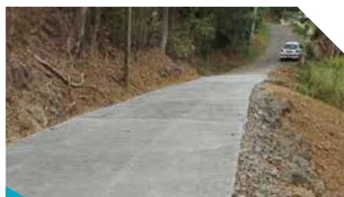
Réalisation d'un mur de soutènement, d'une canalisation pour les eaux pluviales et d'une reprise de revêtement de la route à Kann' Brilé
