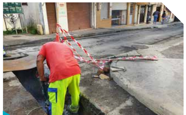
Travaux de canalisation d'eaux pluviales à la rue du Courbaril
