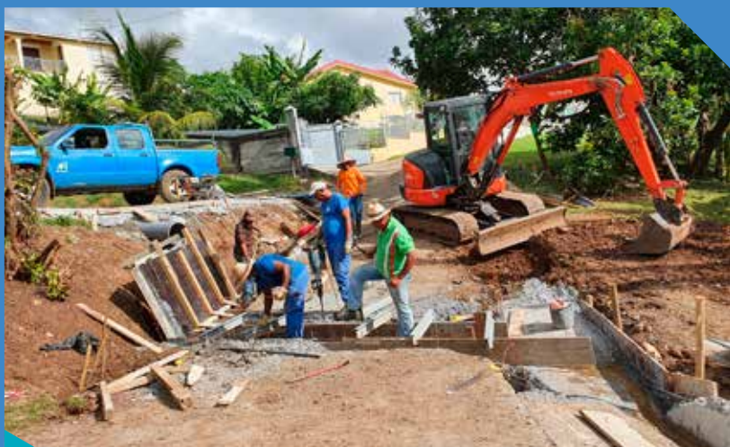
Construction de Traversée de route au quartier Mont-Vert, Chemin Serein
