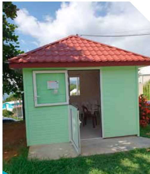
Construction d'un kiosque à la crèche municipale de Pointe Savane
