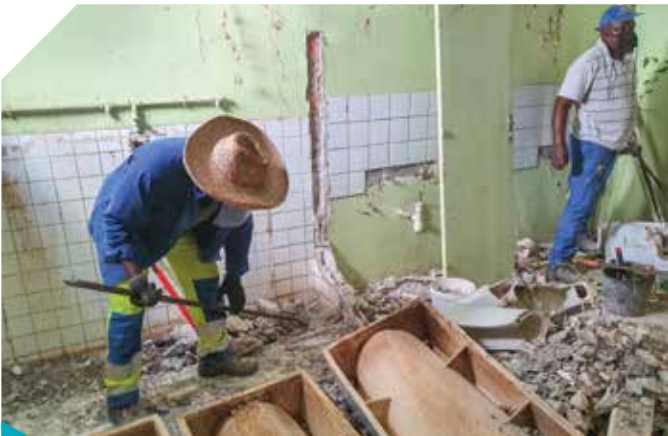
Réfection des latrines publiques
