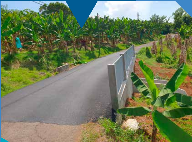
Mur de soutènement et reprise de traversée au quartier Voltaire
