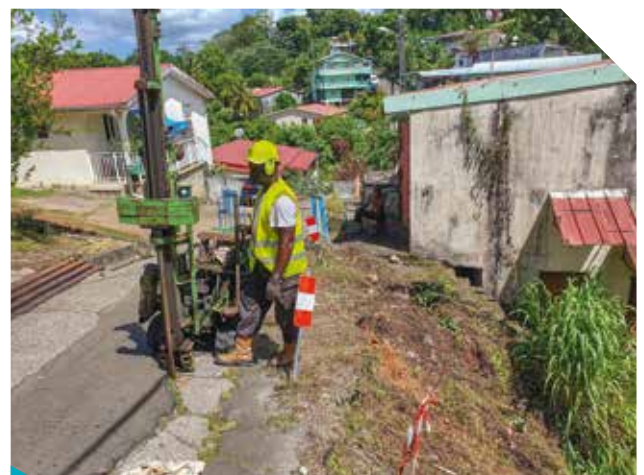
Etude de sol pour la construction d'un mur de soutènement à Fonds d'Or
