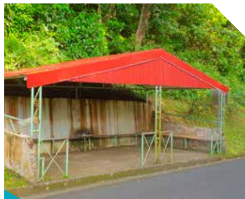
Réfection de la toiture de l'abri bus de la rue des Icaques au Vert Pré
