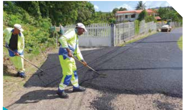
Travaux d'enrobé dans les quartiers Mansarde, Voltaire, Ponthaléry, Pointe Savane, Chère Epice (liste non exhaustive)
