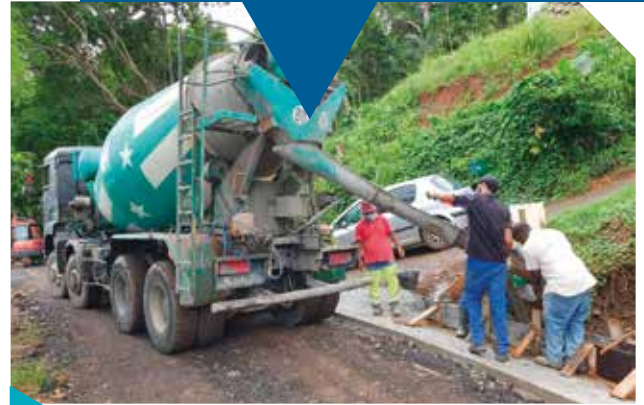
Création d'une nouvelle route de désenclavement au quartier Beauséjour 2
