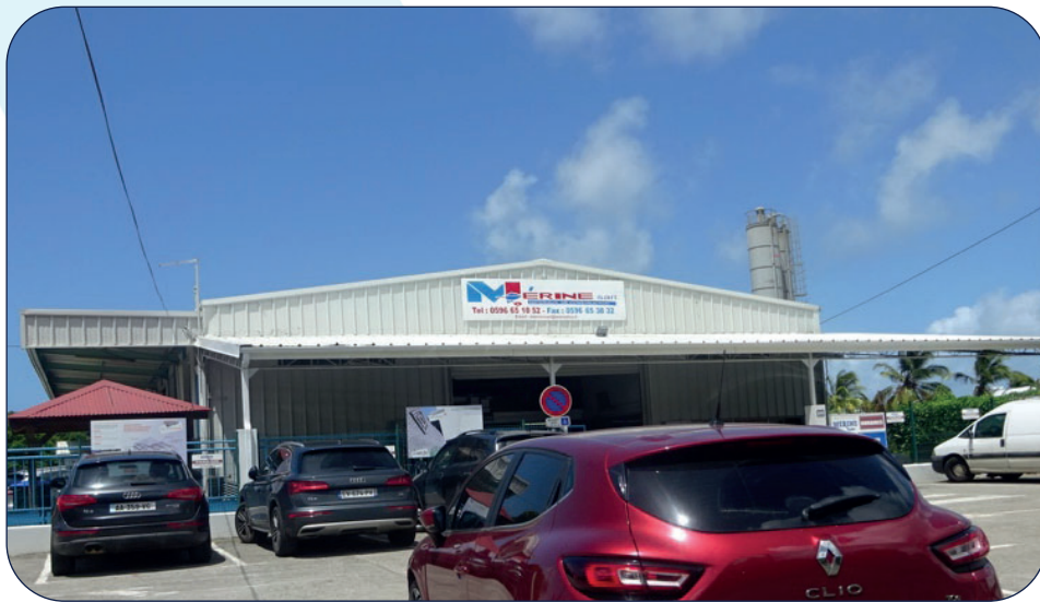
Enseigne dépassant la ligne d'égout
