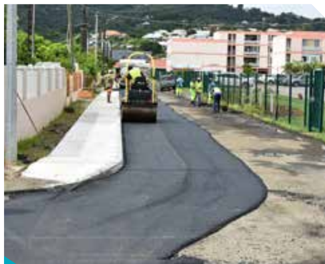
Refection de l'allée des Amandiers du quartier Cité Mansarde 1
