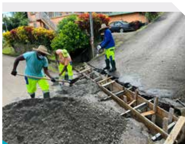
Travaux allée des Amandiers à Cité Mansarde
