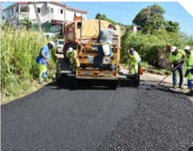
Travaux d'enrobé au quartier Lazaret
