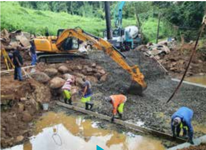
Réfection du pont quartier La Haut
