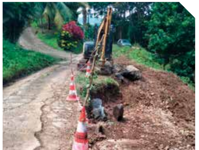
Réfection d'un chemin à Moïse
