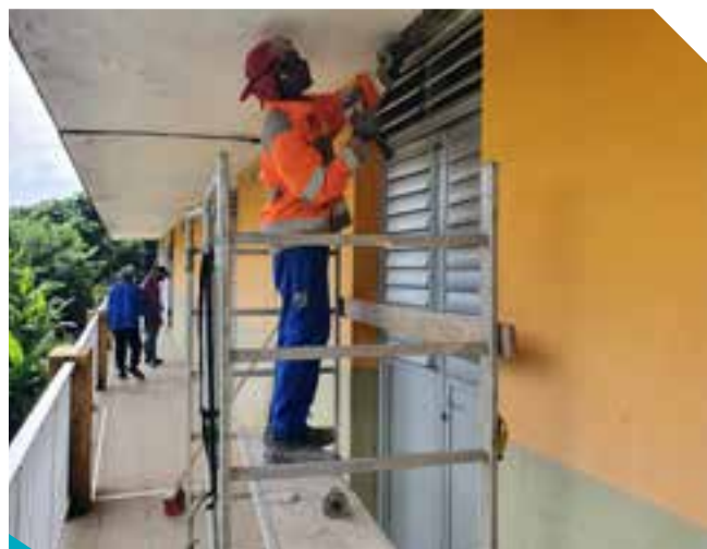
Travaux à l'école « Robert Platon » de Duchesne
